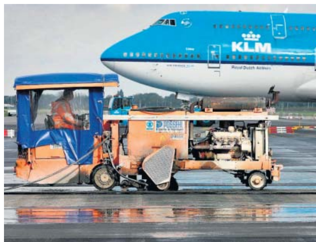
Werkzaamheden aan de Aalsmeerbaan in 2006. De nieuwe toplaag moest worden vervangen.
